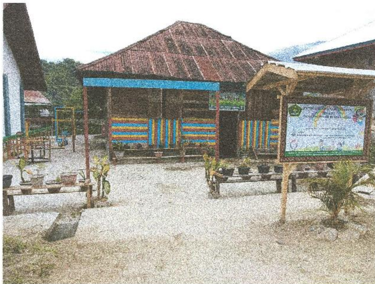
FOTO BANGUNAN TAMPAK DEPAN PAUD T.S. BUNDA KARMEL BUNTUBUDA - MAMASA, SULAWESI BARAT
