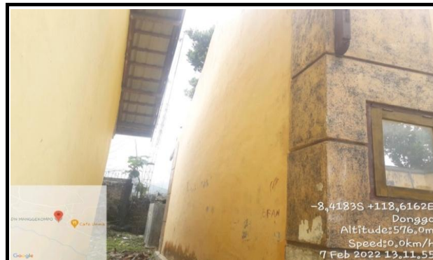
2. TAMPAK SAMPING KANAN RUANG
